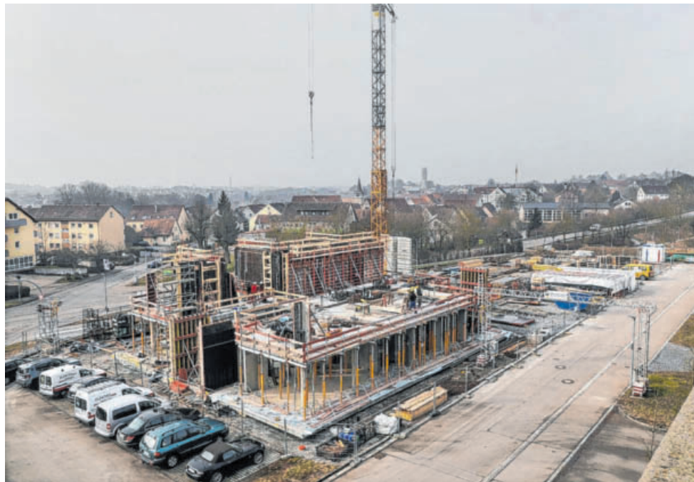
Fortschritt: Das neue, repräsentative Gebäude im Solpark feiert in Kürze Richtfest.
